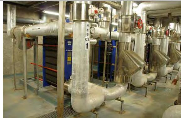
圖 3. 海洋深層水機房內的冷交換機設備。
