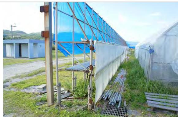
圖 6. 溫室設施旁新建的抗風設施，有助於颱風期間減少溫室損失。
