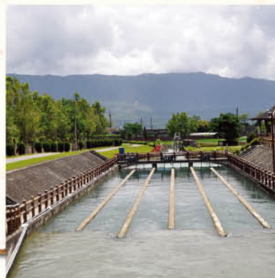
池上圳沉砂池
