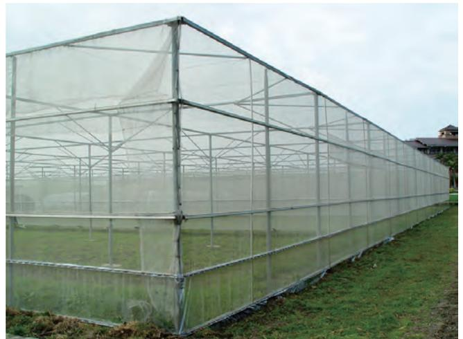
圖1. 鍍鋅鐵搭架，水平棚架結構網室。
