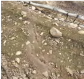
熱帶火蟻小沙丘狀蟻穴沿水泥裂隙散布
