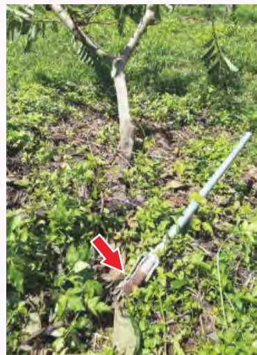
鋁管基部鏽蝕應儘早更新，避免受風時支柱斷裂。
