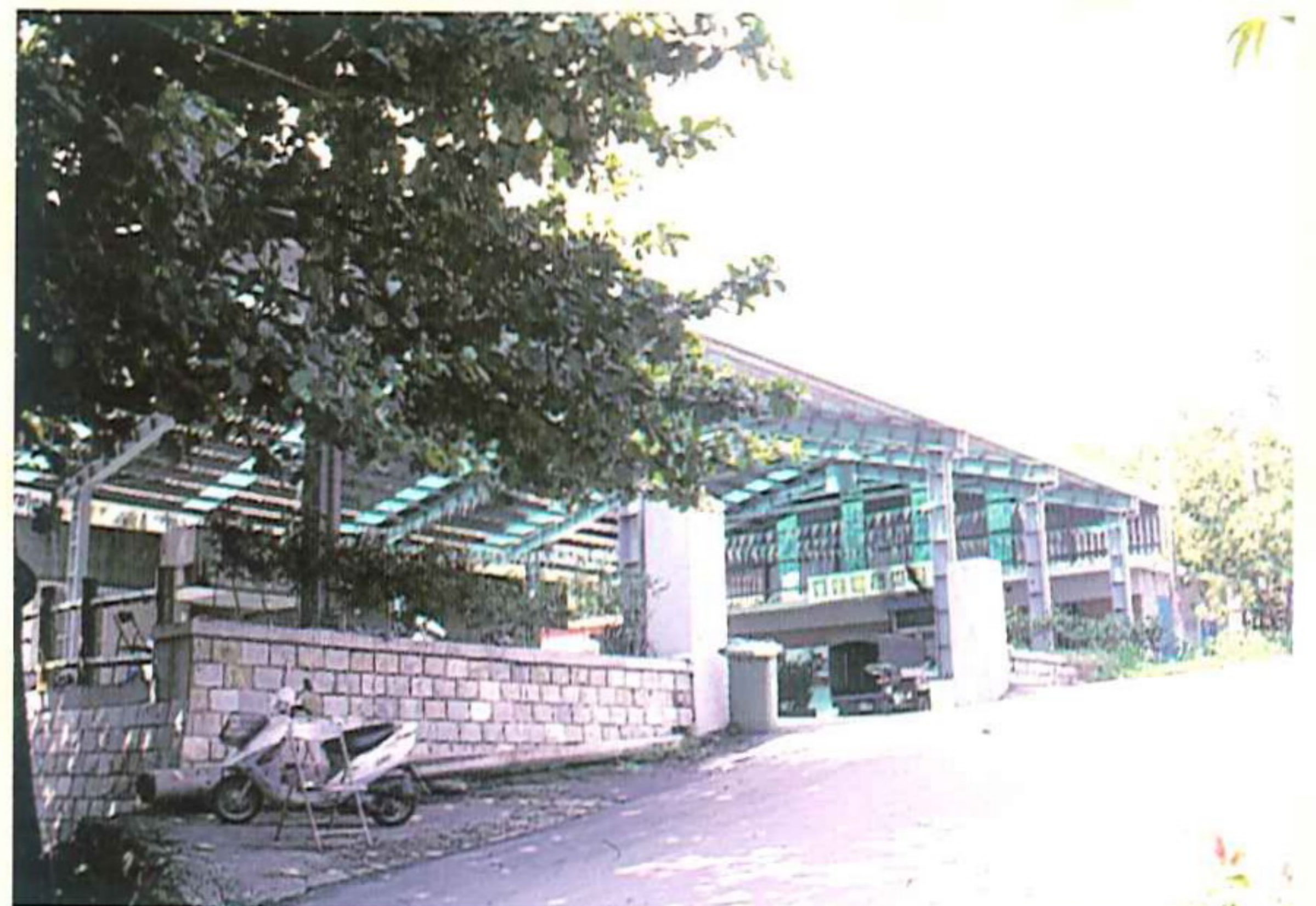
▲ 太麻里鄉華源村整建華源社區活動中心之棚架設施
